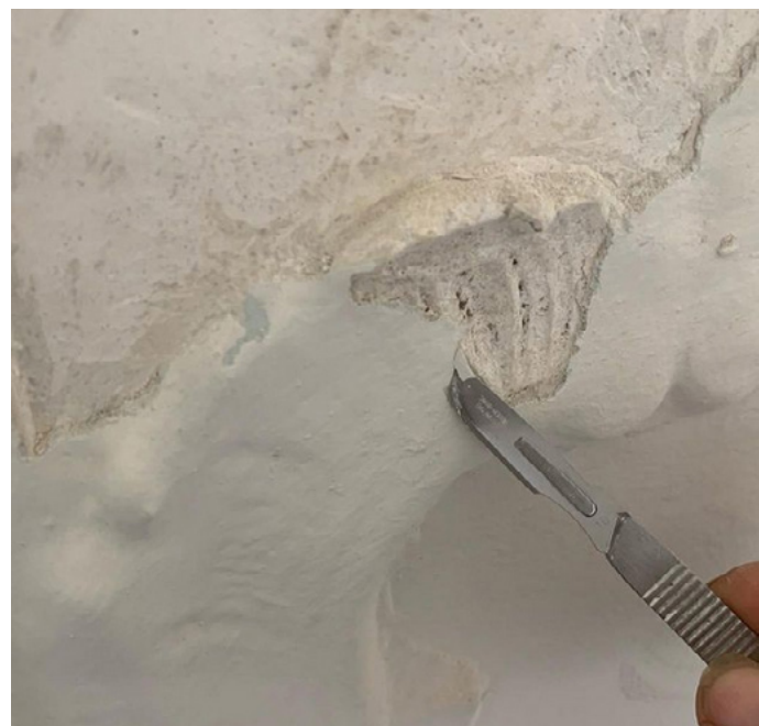
Restauration d'un décor de gypserie : dégagement et réparation. Château, Aubenas, classé MH (CT pour Atelier Sud France, 2023)
